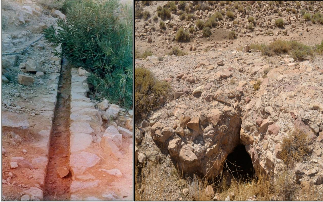
الصورة 45: صهريج القاهرة
